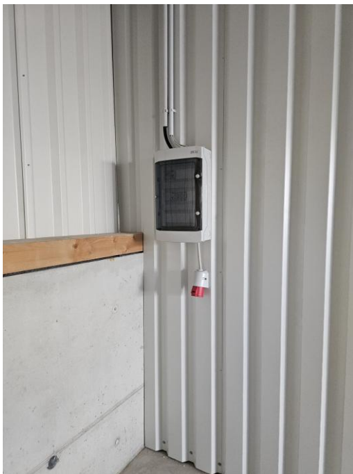
400-V-Starkstromanschluss
